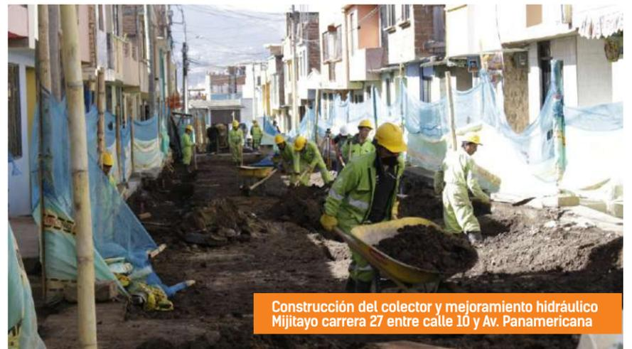
Construcción del colector y mejoramiento hidráulico Mijitayo carrera 27 entre calle 10 y Av. Panamericana
