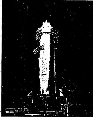
Es una antorcha que realiza la quema de los gases provenientes del Vaso de Disposición Final de los residuos sólidos que llegan al Parque Tecnológico Ambiental Antanas, con una Reducción de 5353 Ton CO2 desde el año 2020.
