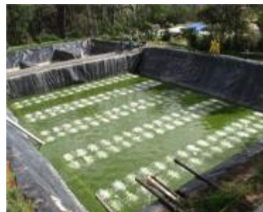
Reactor de lodos activados
